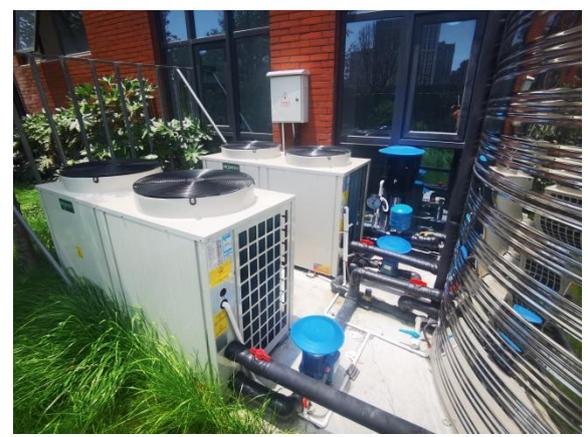
空气源热泵热水机组
