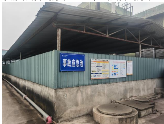
厂区事故应急池
