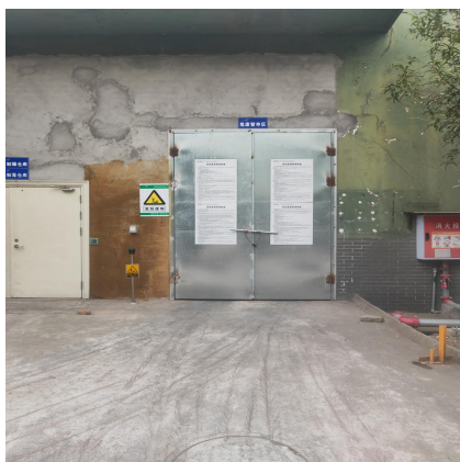
厂区危废暂存间
