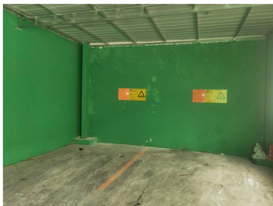
危废暂存间内部防渗
