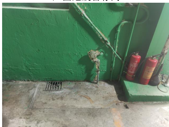
危废暂存间收集池及应急设施
