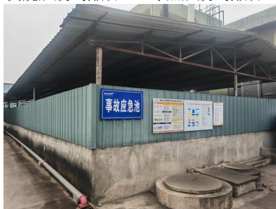
厂区事故应急池
