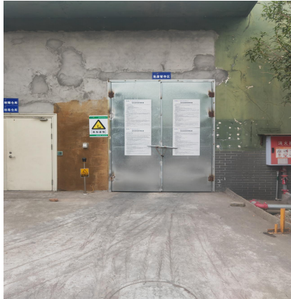
厂区危废暂存间
