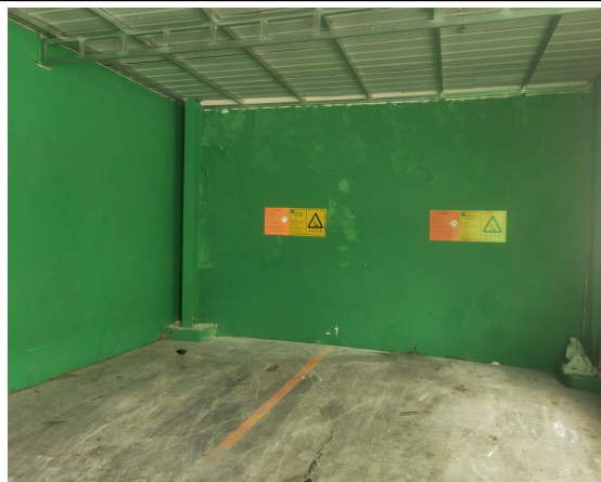
危废暂存间内部防渗及标识
