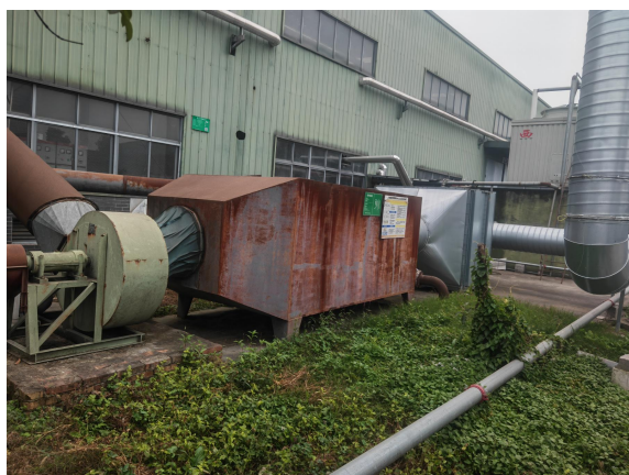
二级活性炭处理设施
